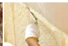
現場吹きつけ発砲ウレタン
